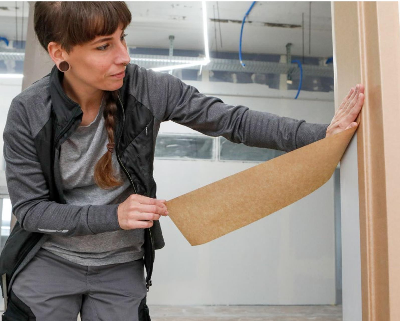
Das neue selbstklebende und universelle Abdeckpapier ist rückstandslos entfernbar, innen bis zu 6 Monaten. Es haftet auf horizontalen und vertikalen Oberflächen und besitzt eine gute Wasser- und Lösemittelbeständigkeit. Mehr erfahren oder direkt bestellen unter: 071 844 12 12.
