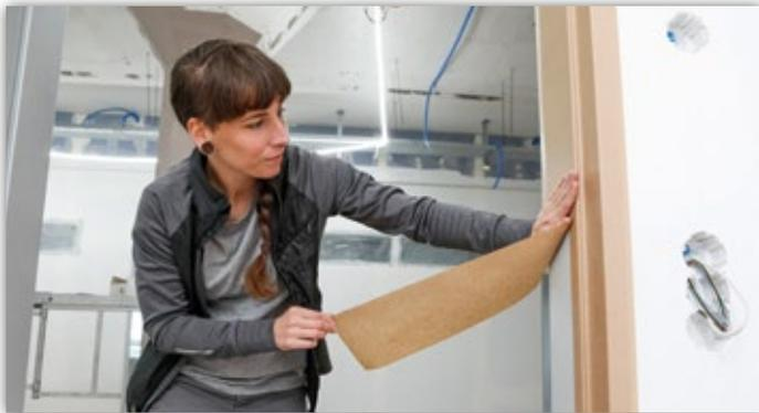
Das selbstklebende Abdeckpapier bietet nicht nur auf Böden einen sicheren Schutz, ohne zu verrutschen, es haftet auch an Wänden und Decken.
